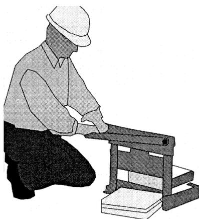
Рисунок 23 – Изготовление дополнительных элементов с помощью гильотины
