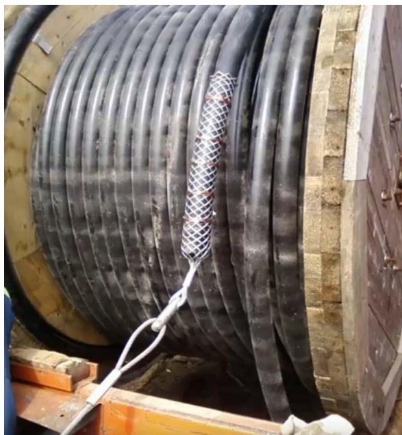
Рисунок 1 – Протяжка кабеля с использованием кабельного чулка
